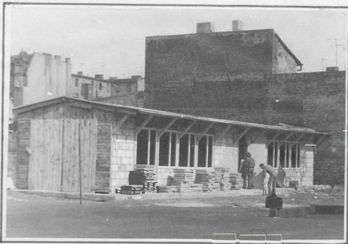
Harcówka w trakcie budowy
